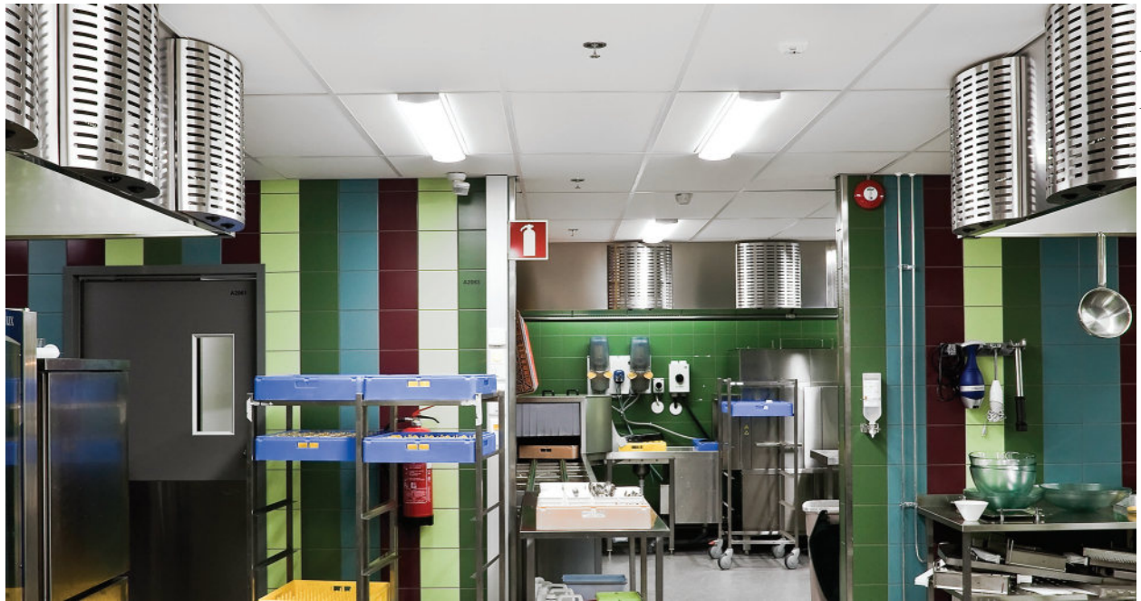
Technopolis Yliopistorinne, Finland
